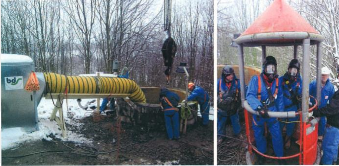
Erkundung des Sickerwasserzentralschachtes durch Einfahrt mit Vollschutz (2013)
