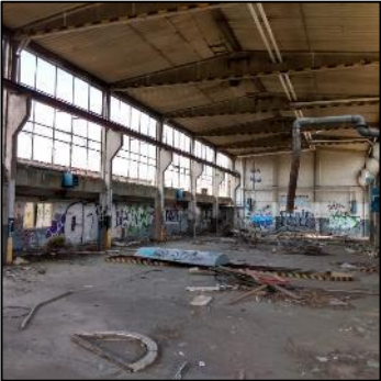
Gebäudeschadstoffe und Rückbau
